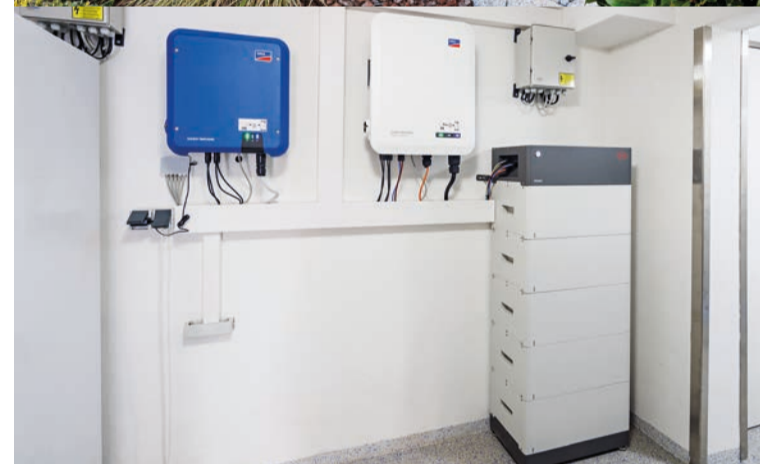
Wärmepumpe von der Firma Remco (oben) sowie Wechselrichter der PV-Anlage und Batteriespeicher (unten)
