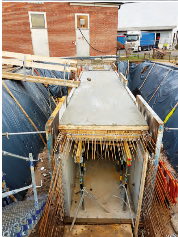
Oben rechts: Anschlüsse am neuen Trafohaus. Mitte: Alles wieder eben. Die Situation nach den Bauarbeiten. Oben: Helen Guwa und Siegfried Eckert besprechen die Umverlegung von Bestandsleitungen für den neuen Kanal. Links: Querschnitt durch den neuen Kabelkanal
