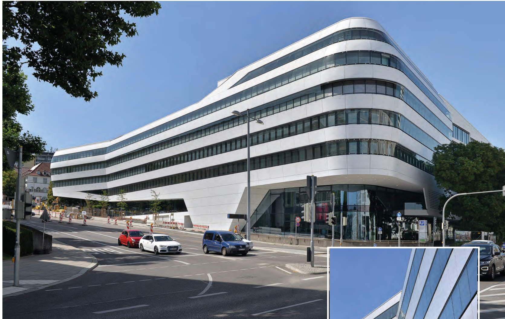
Architektonisches Schmuckstück an der Heilbronner Straße
