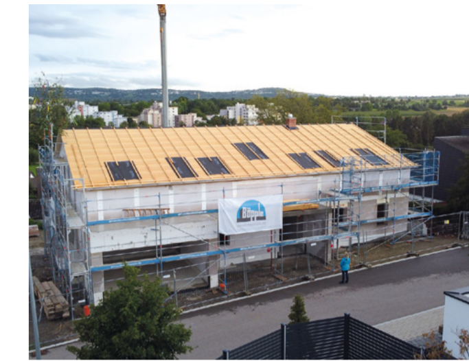
Links: Die Bauherren (rechts: Familie Gackstatter zusammen mit Böpple-Mitarbeitern) beim Richtfest Unten: Luftaufnahme des Rohbaus
