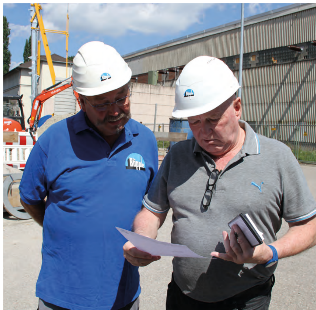
Achim Hannemann prüft auf der Baustelle mit Polier Manfred Betz (links) die Bauausführung
